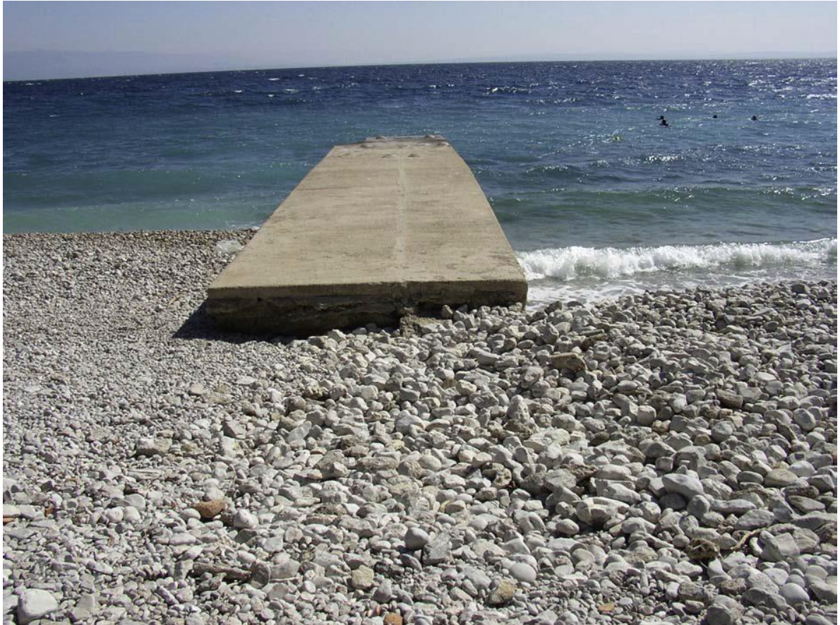
Slika 11. Utjecaj betonskog mola na šljunčanu plažu (izvor: Juračić M. i sur. 2009)
